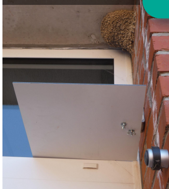
Planchette ajustée contre la fenêtre et laissant 1 cm entre elle et le mur Photo : L. Leite
